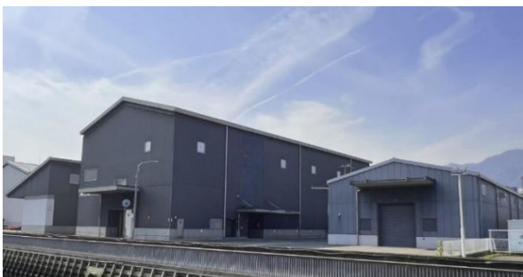
△灘大石工場外観
